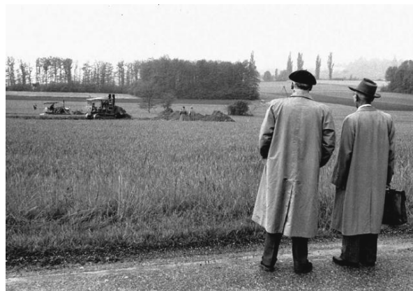
Obr. 1.2 Prvé výkopové práce 17. mája 1954 na mieste budúceho CERN-u na švajčiarsko-francúzskej hranici neďaleko Ženevy
